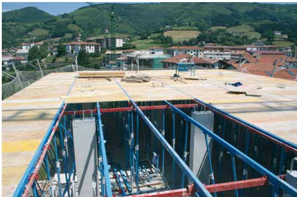
Estrutura pronta para concretagem.
