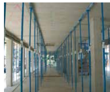
Escoramento parcial até cura completa do concreto.
