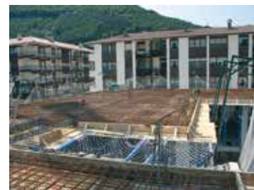
Estrutura pronta para concretagem.
