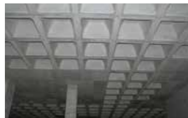
Acabamento perfeito após a concretagem
